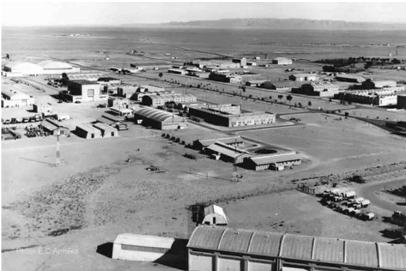
▲ ▼ Colomb Béchar-Léger, vues générales, l'aérodrome est en haut
